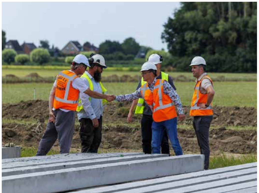
Start van de bouw van het Trial Centre Open Field van fruit- en groenteveredelingsbedrijf Rijk Zwaan.
